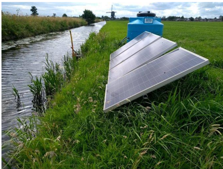
Pompgestuurde infiltratie veenweidegebied, waarbij zonnepanelen energie voor de pompen opwekken (foto: https://www.zuid-holland.nl/actueel/nieuws/februari-2021/uitbreiding-valuta-veen-winst-boeren-natuur/ )
