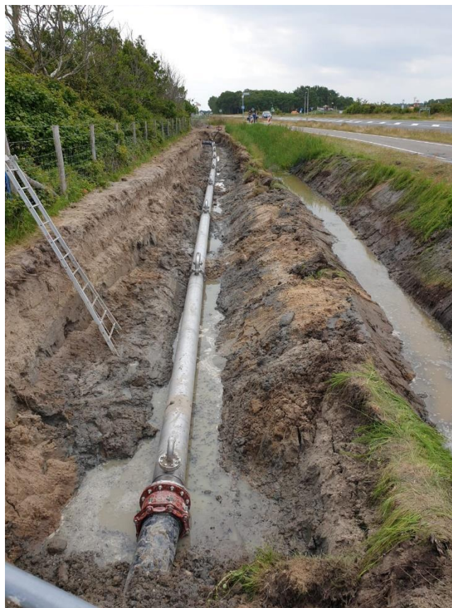
Voorbereidingen project Zwembad de Veldkamp, Wezep (foto: Simon Bos)
